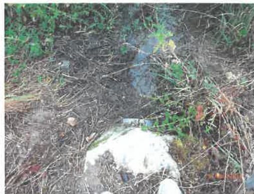
Canalisation de rejet
